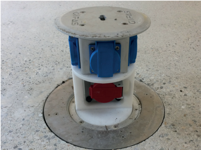
Sol en béton
