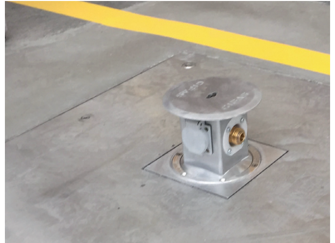
Halle de stockage
